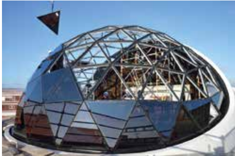
Geodätische Kuppeln, seit den 1940er Jahren von Richard Buckminster Fuller entwickelt, sind Gitterstrukturen, die Leichtigkeit mit stabiler Konstruktion verbinden.
