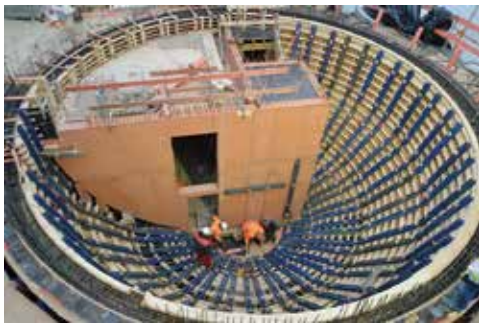
Die Holzschalung der unteren Kugelhälfte vor Einfüllen des Betons. Im Inneren sieht man die Hausecke des Bestandsgebäudes mit dem angrenzenden Fahrstuhlschacht.
